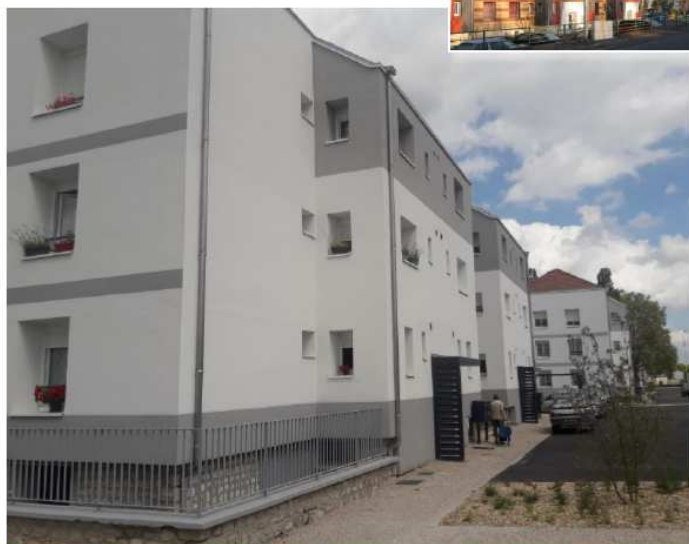
Cosne-sur-Loire – Binot Réhabilitation de 36 logements
