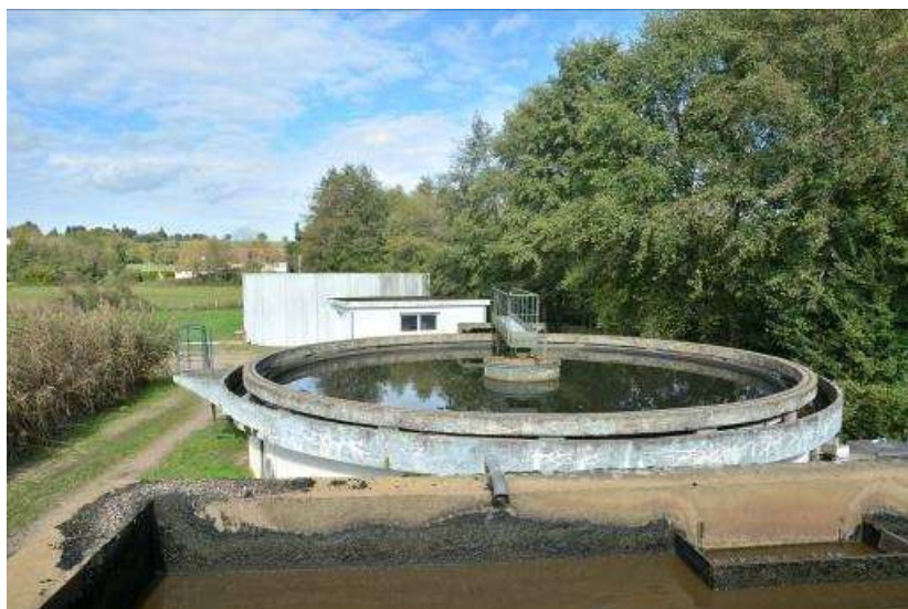
Station d'épuration de Corbigny
