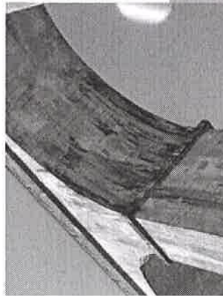
Aqueduc de Montreuillon
