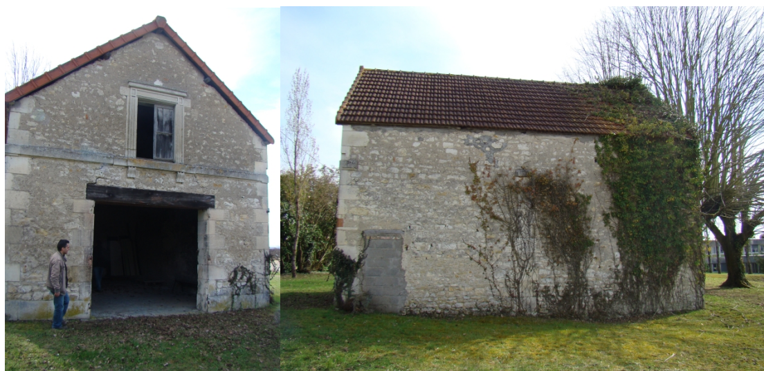
Vues du bâtiment annexe
